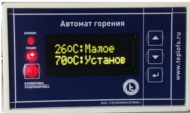
4) При работе котла на дисплее отображается информация о текущей и установленной температуре воды, а также о режиме работы горелки «малое»/ «большое» горение.
