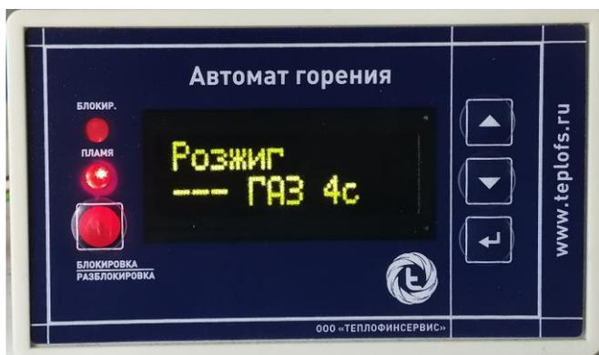
На случай не удачной попытки розжига или погасания пламени запальника в момент розжига, автомат горения имеет функцию повторного пуска, после трёх не удачных попыток котёл уходит в аварию, на экране отображается надпись: «Нет пламени»
